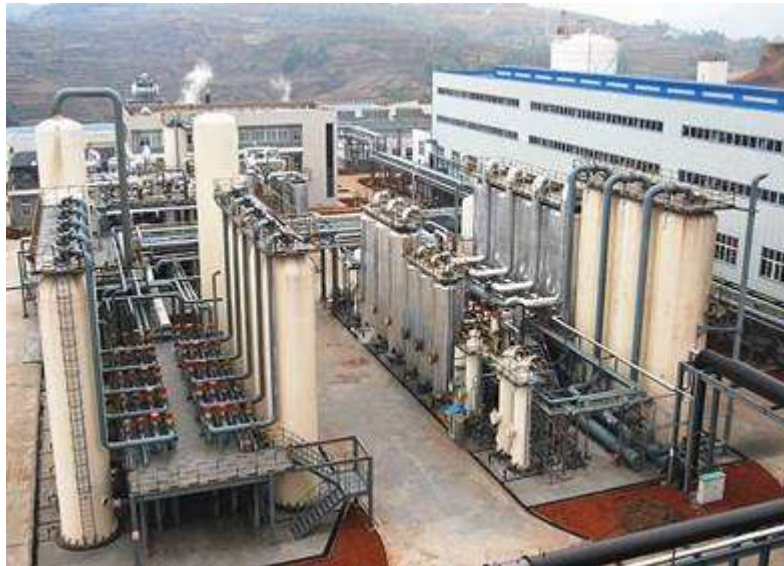
Ilustración 17. Planta de producción de hidrógeno por reformado con vapor.
